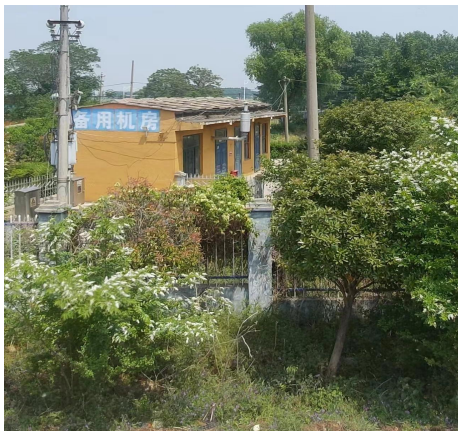
备用机房现状
