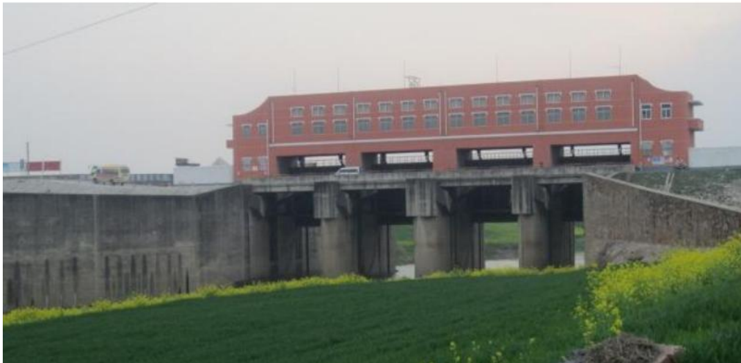
图 1 杨庄泄洪闸现状图
