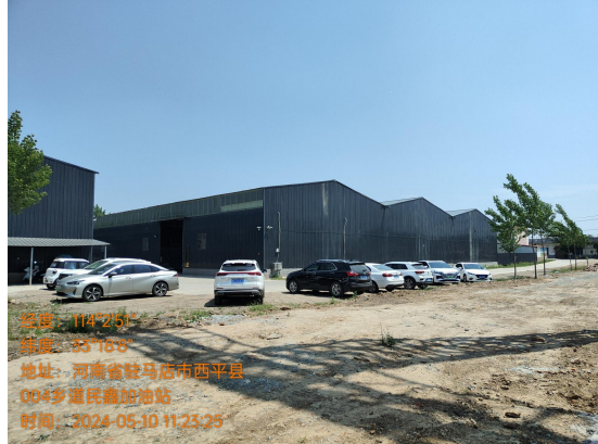
厂区北侧机加工公司
