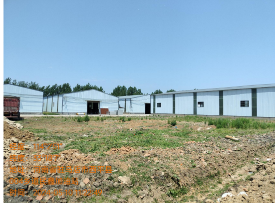
厂区西侧机加工公司
