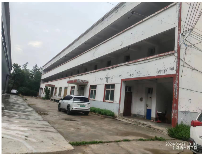
项目北侧的闲置房
