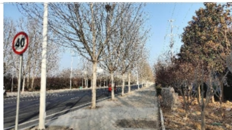
项目北侧（金凤大道）
