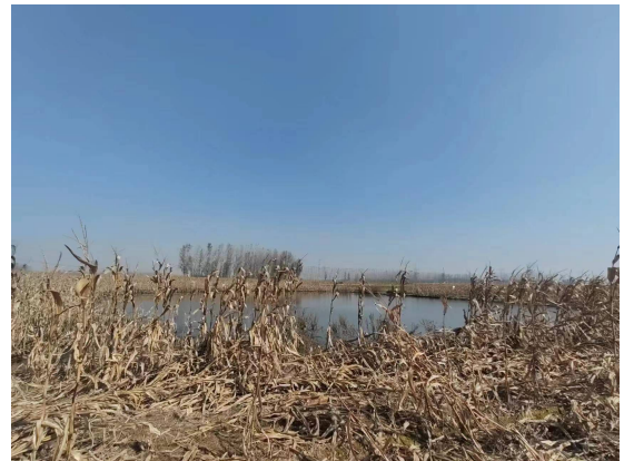
2 号风电机组及开关站现状
