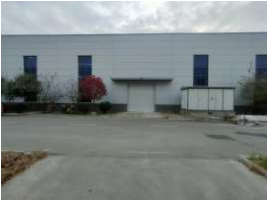
项目北侧（空厂房）
