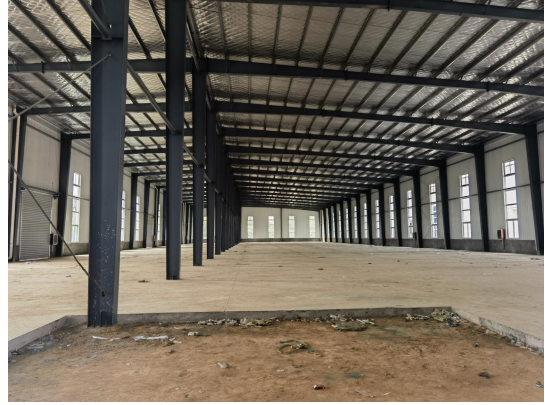
项目所在 11 号厂房现状
