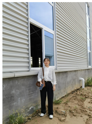
工程师现场踏勘
