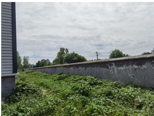
西侧园区围墙
