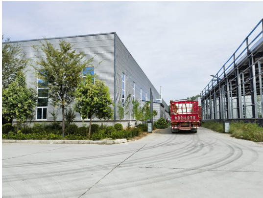
东侧 21 号厂房和在建 22 号厂房
